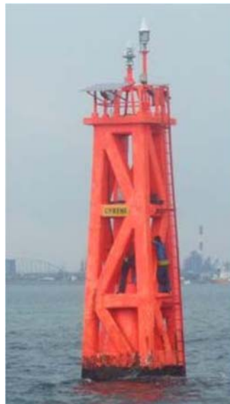
Figure 31 Exemple de structure porteuse utilisée comme marque de jour
