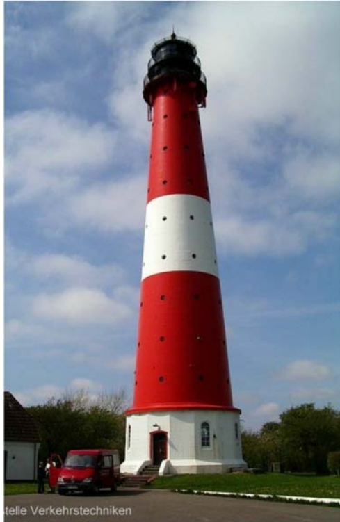
Figure 32 Exemple d'utilisation de bandes horizontales rouges et blanches
